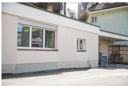
Ansicht vom Parkplatz
